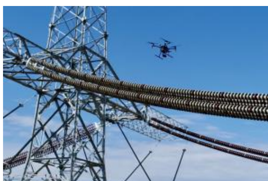
(a) DJI 电力巡检无人机解决方案
